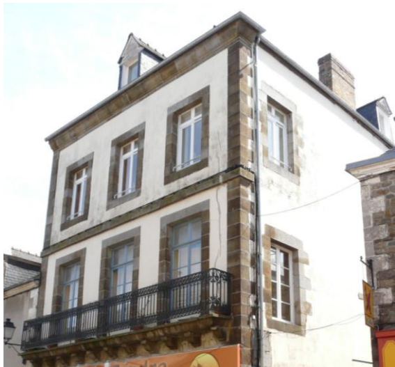
L'enduit met en relief l'architecture des encadrements et tout le dessin de pierre de taille.
